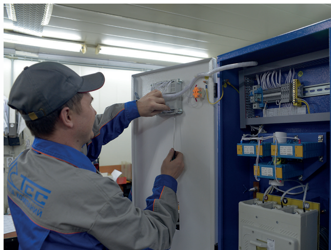
СБОРКА ЩИТОВ УПРАВЛЕНИЯ
