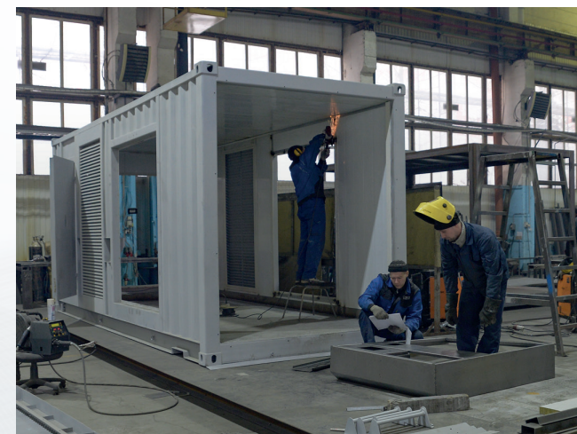
ЦЕХ ИЗГОТОВЛЕНИЯ КОНТЕЙНЕРОВ
